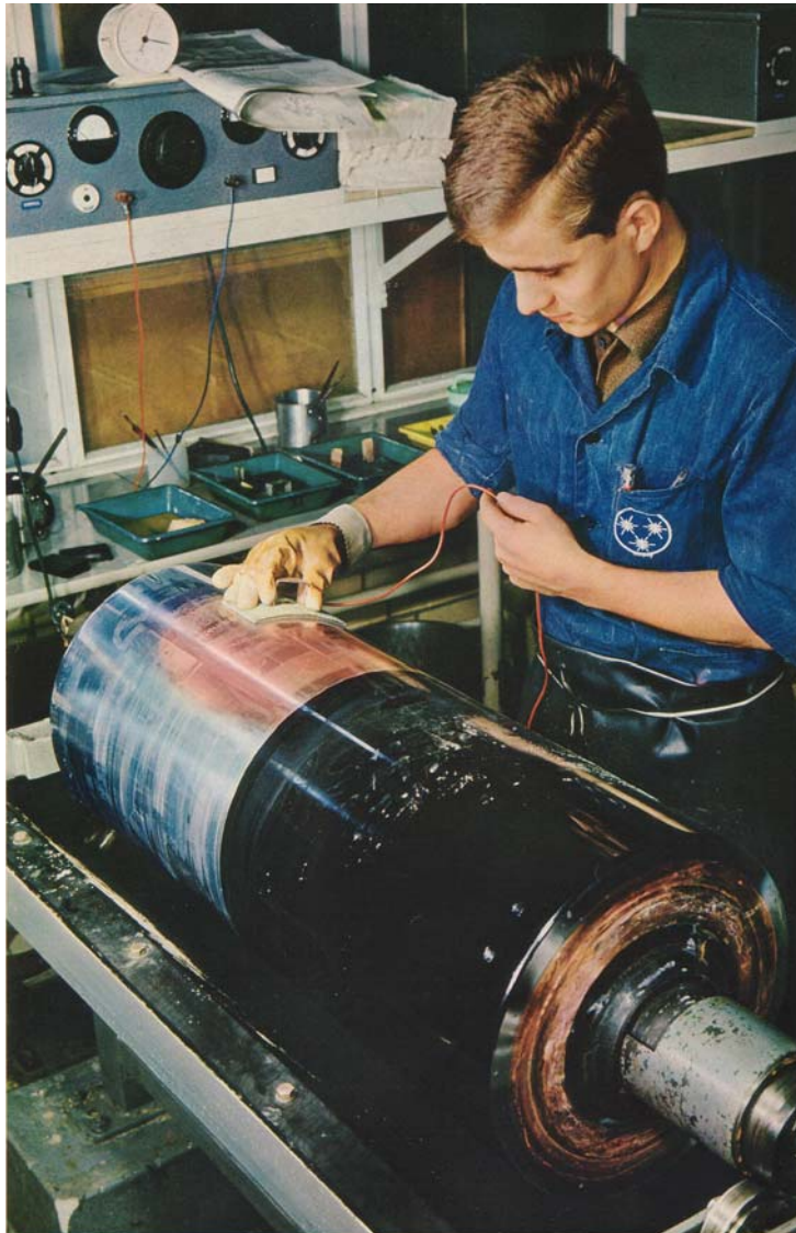
Abb. 83.1. Galvanische Minuskorrektur (Dalie) auf verchromtem Zylinder nach dem Andruck.
